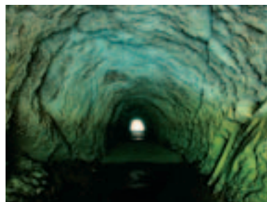
素掘り隧道（ずいどう）の柳谷（やなぎたに）トンネル。
