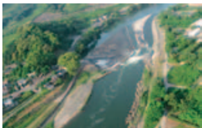
現在の山田堰の全景。
